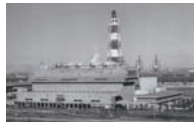
1973年に東京都に竣工した大井清掃工場は、ごみ質の変化や粗大ごみ収集の開始などにあわせて、焼却炉の設計・設備の向上、粗大ごみ破碎機、ごみ積替設備を備えた大規模工場としてごみ問題解決に寄与した。
