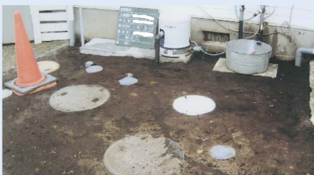
7. 雨水貯留槽 完成
