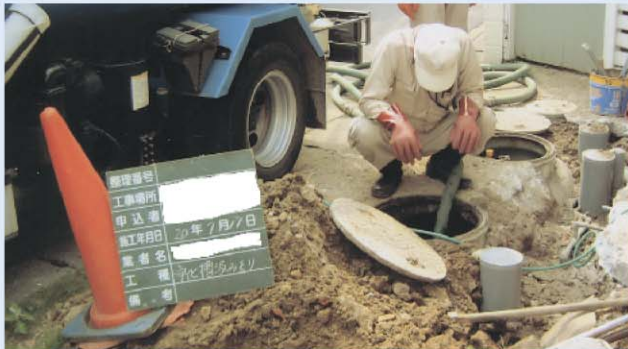
1. 浄化槽汲取り
