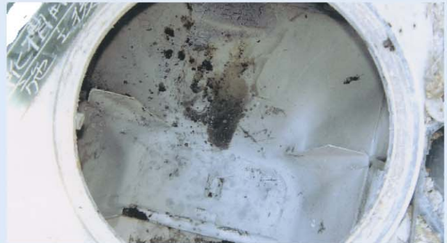
2. 浄化槽解体施工
