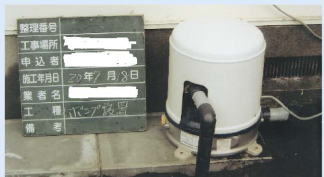
6. 水中ポンプ設置
