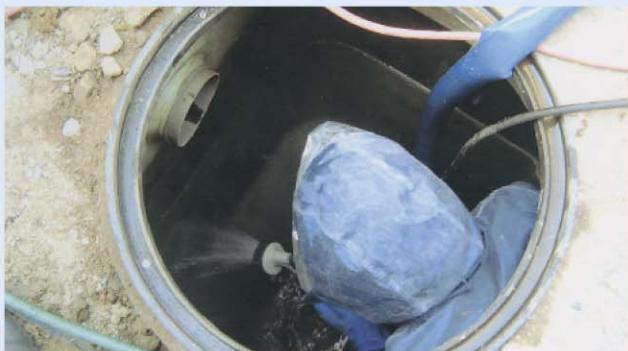
3. 浄化槽内清掃
